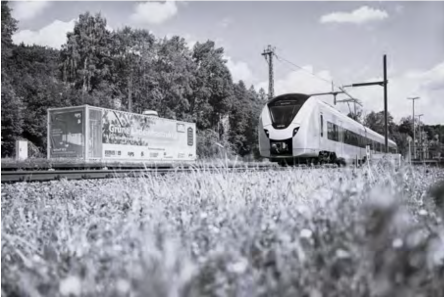
Abbildung 4: Annaberg-Buchholz - Ladeinfrastruktur Akkuzug (Quelle: DB Energie GmbH / Max Lautenschläger)
