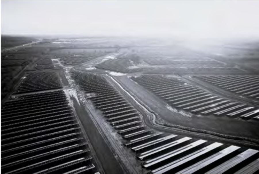
Abbildung 3: PV-Park Wasbek (Quelle: DB AG/Enerparc AG)
