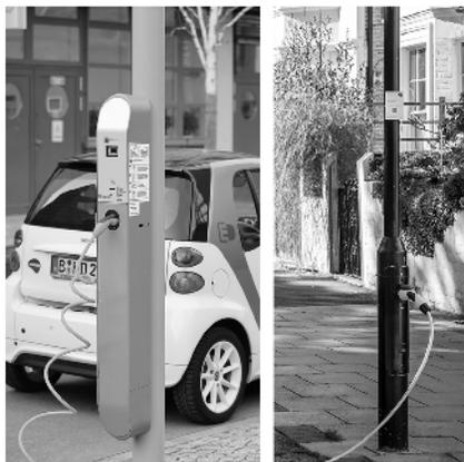
*Abbildung 1: Gegenüberstellung der Lösungen DE (links): Anwendung der Standard-TAB für Hausanschlüsse und UK (rechts): Nachrüstung eines bestehenden Lichtmasts mit angepassten Vorgaben zum Netzanschluss neuer Produktgruppe (Ladeinfrastruktur)*
